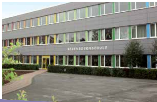
Ansicht der Südfassade mit dem Haupteingang
