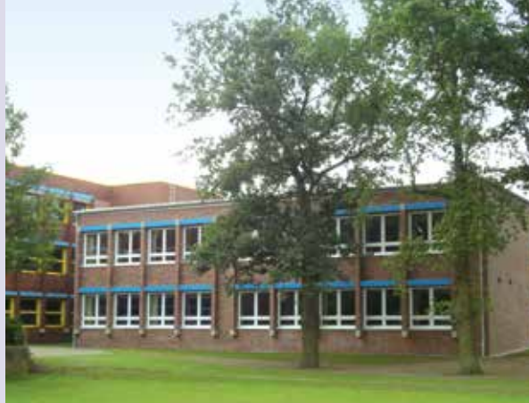
Ansicht des Erweiterungsneubaus, Berufskolleg in Warendorf
