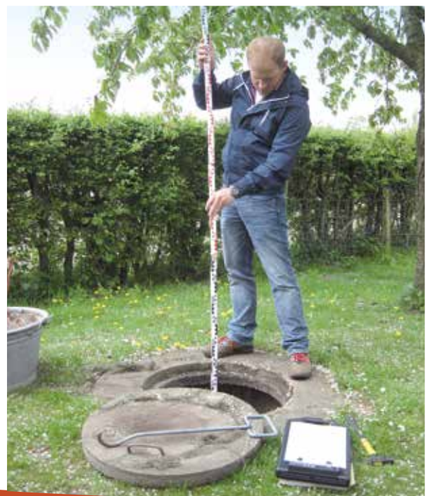
Kontrolle einer Kleinkläranlage
