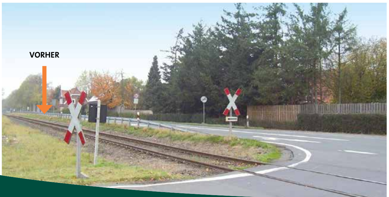
Die Schutzplanken sind sichtbehindernd für Linksabbieger aus der K 19
