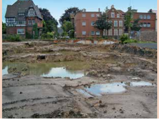
Altstandort "ehemaliges Emallierwerk", während des Rückbaus...
