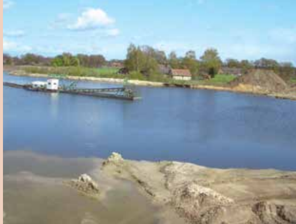
Tiefentsandung mit Schwimmbagger im Betrieb
