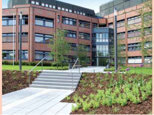
Seit Anfang 2014 hat das Kreishaus einen neuen Eingang
