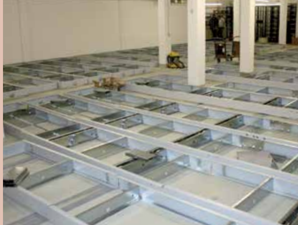
Einbau der Rollregalanlage 2010
