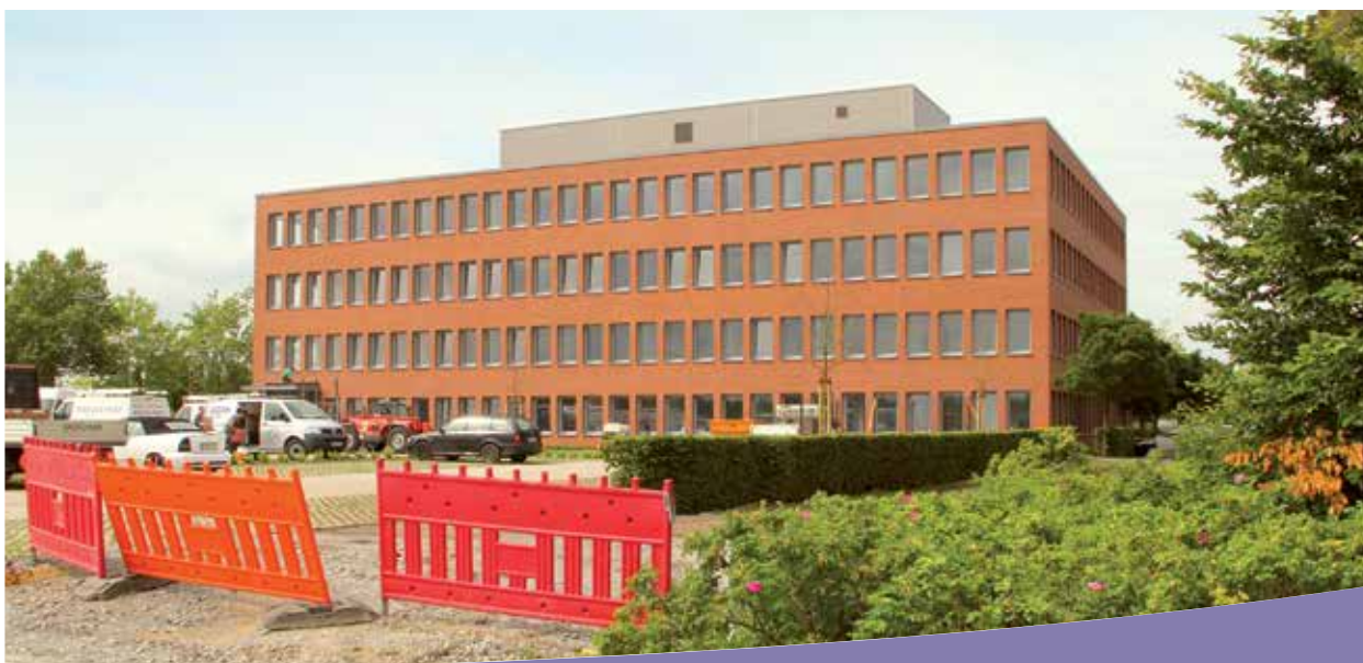
Ansicht der Baustelle des neuen Gebäudes
