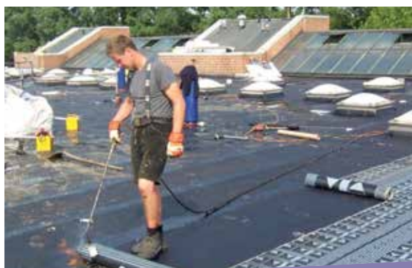
Aufbringen der Dachdichtungsbahnen
