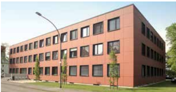
Ansicht der Südfassade des Jobcenters Ahlen
