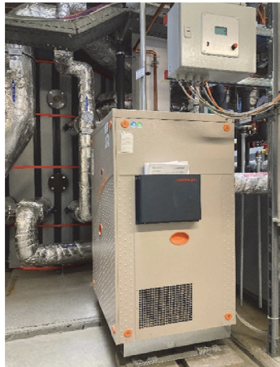
Gaswärmepumpe Kreishaus
